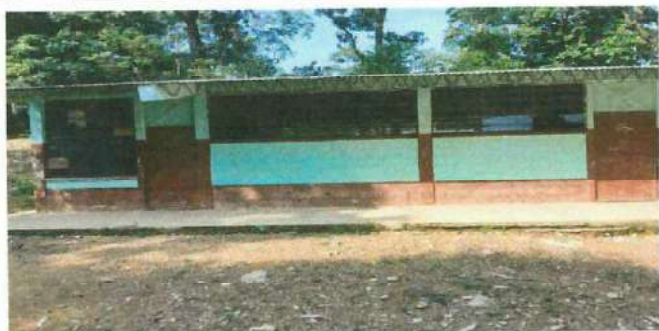
Foto 3: Sustitucion de 5 puertas de metal.
