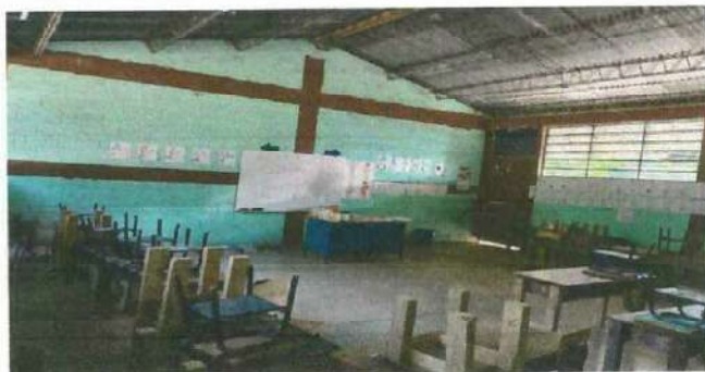
Foto2: Sustitucion de Estructura metalica, por tubos cuadrados galvanizados.
