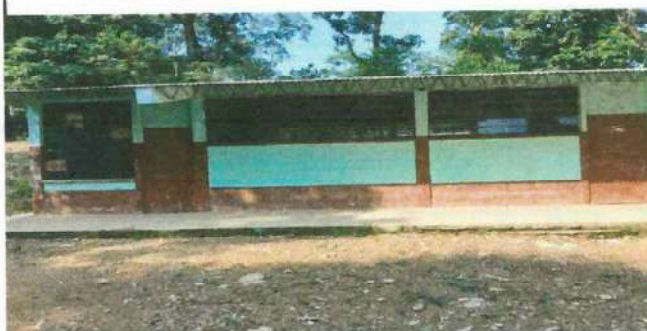
Foto 4: instalacion de canal para el agua pluvial.
