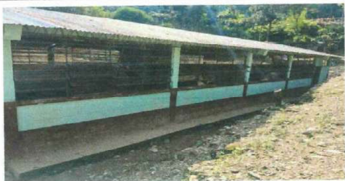
Foto 1: Sustitución de entechado, por laminas troqueladas.
